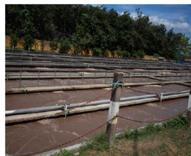
図 6 工業用廃水処理装置
