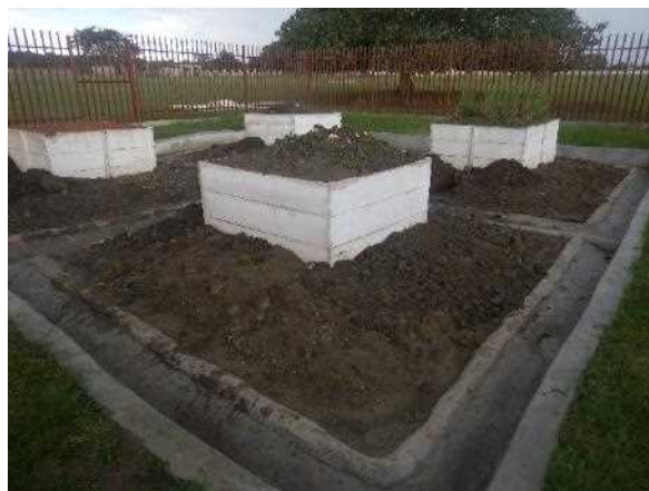
UNZA 敷地内に造成したパイロット試験場
