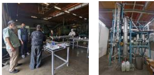
図 27 バイオメタノール製造試験後の設備等の確認
