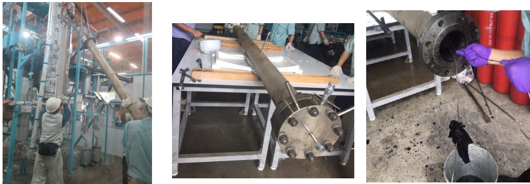
図 26 運転後の設備等の確認・メンテナンス
