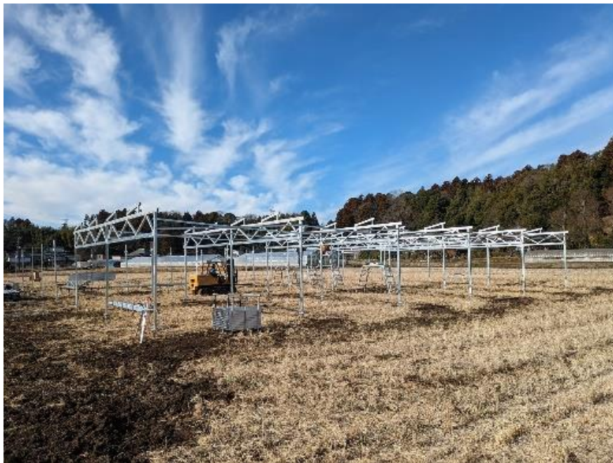
図9 新設水田ソーラーシェアリングの施工風景
