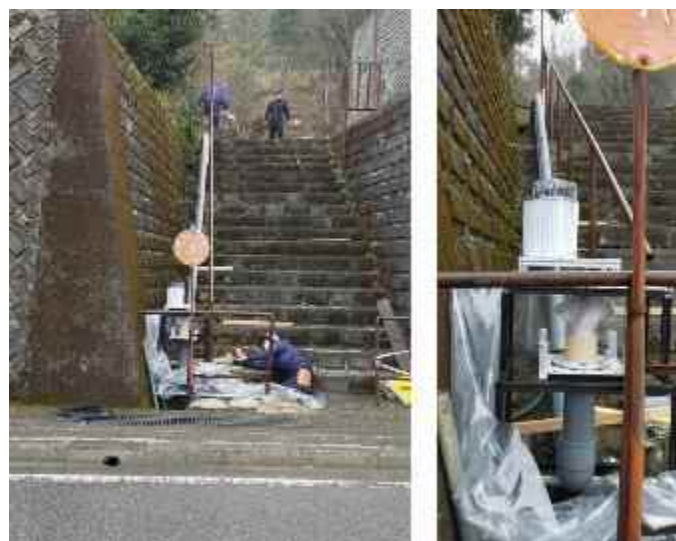
図 21 水車の設置状況 道路からよく見える場所に設置
