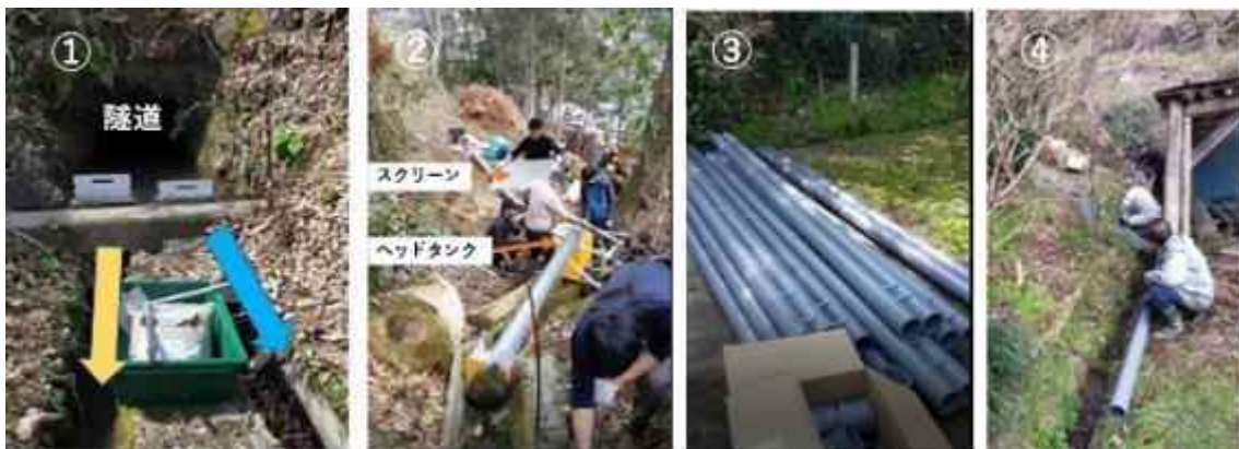
図 16 導水管の設置状況 ①隧道から出てくる用水路のうち水色の水路を活用、②ヘッドタンクやスクリーンの設置状況、③使用する塩ビパイプ、④平らな敷地部での設置状況
