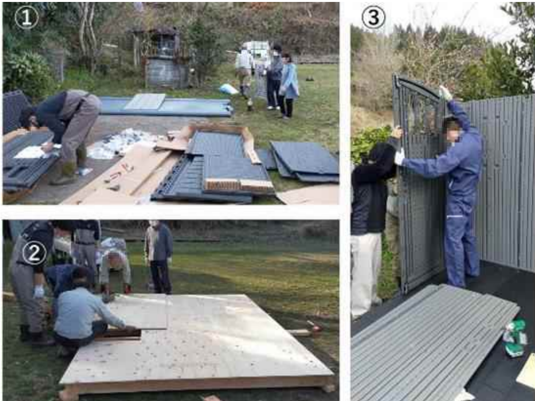
図 17 発電小屋の設置状況 ①並べた部品 相当の数がある、②発電小屋のプレハブの床の製作、地元の人が中心になり実施された、③壁を設置しているところ
