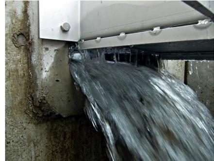
図8 除塵装置による取水
