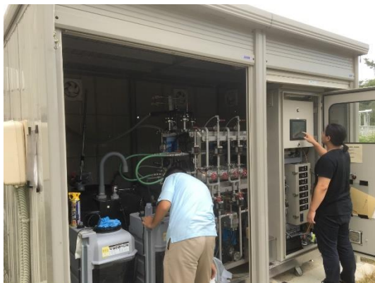
実証プラントでの作業の様子
