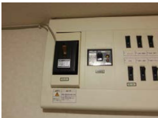
家庭内配電盤からの電力の測定
