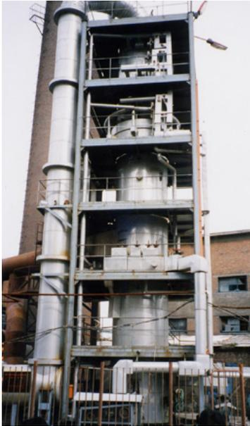
Fig. 2 低コストの水膜式脱硫装置
